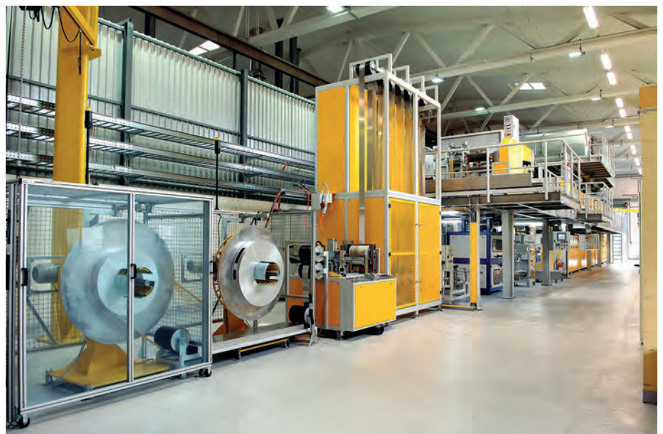
Abb. 2: Die vor zwölf Jahren neu gebaute Lackieranlage von Griesser kommt aufgrund des Einsatzes von AD-Plasma ohne eine nasschemische Reinigungsstraße aus (Bild: Plasmatreteat)
